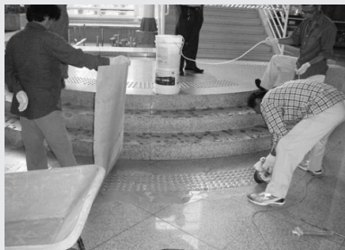
▲ 시청사 내부의 계단 앞에 점자블록을 설치하는 모습
